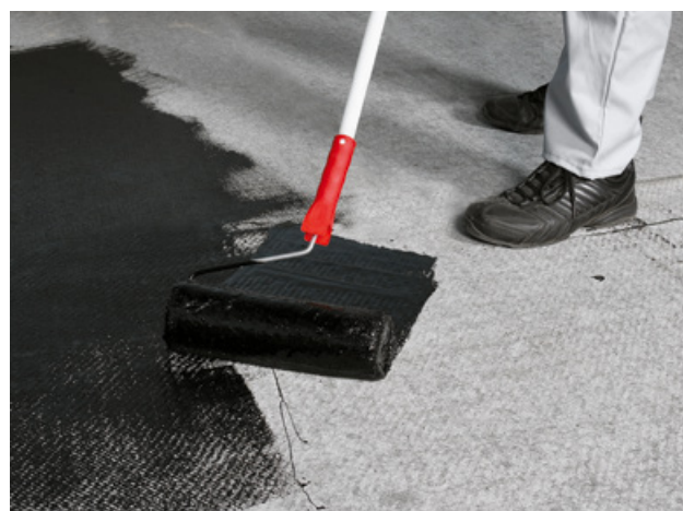
Рис. 4.7. Нанесение грунтовок.
