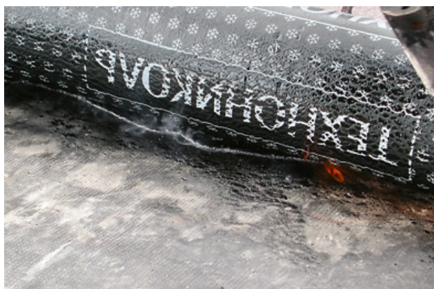
Рис. 4.15. Валик расплавленного битумно-полимерного вяжущего
