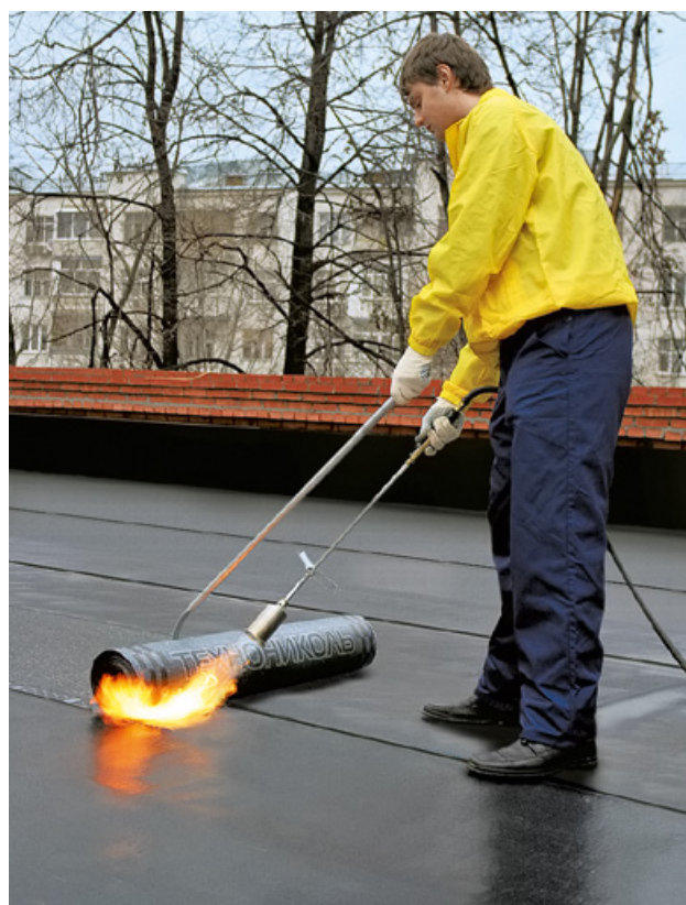
Рис. 4.13. Положение рабочего при укладке.
