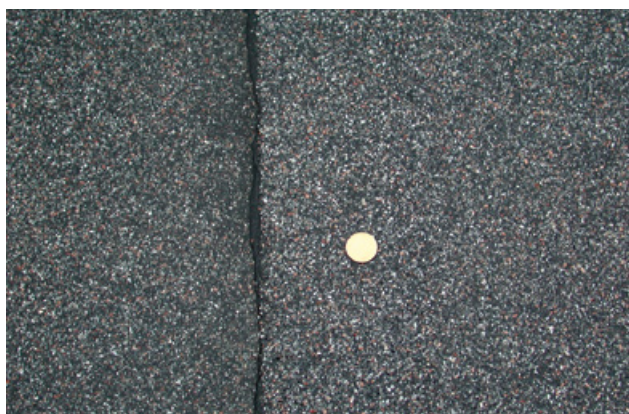
Рис. 4.16. Битумно-полимерное вяжущее, вытекшее из-под кромки материала (для сравнения монета 10 коп.)
